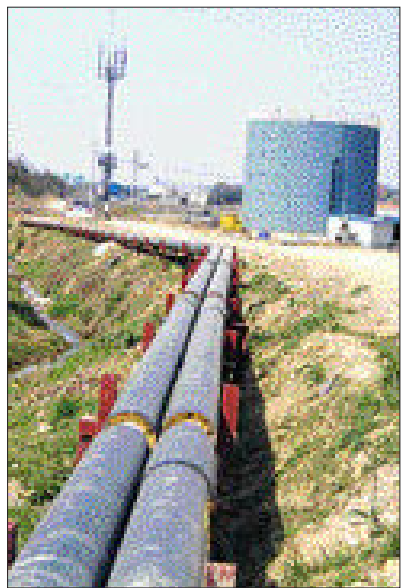
무안군이 삼향면 유교리에 전국 처음으로 원형한 소각로 폐열을 이용한 난방 시설인 축열조 옆으로 따뜻한 물을 옮기는 이송관과가 지고 있다. 동안 난방효과 등을 정밀하게 검증한 뒤 실효성이 입증되면 이 같은 시설을 크게 확대하는 방안을 검토하겠다"고 말했다. /무안=이원희기자 whlee@
