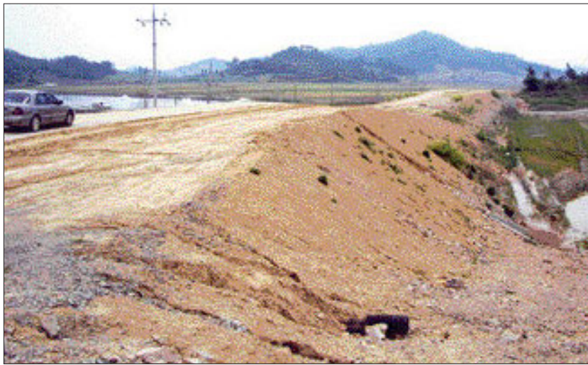
신안군 암태면~팔금면을 잇는 연도교의 팔금면쪽 접속도로의 지반이 침하, 토사가 인근 버논으로 유실돼 농수로를 막고 있다. /신안=조원남기자 wncho@
