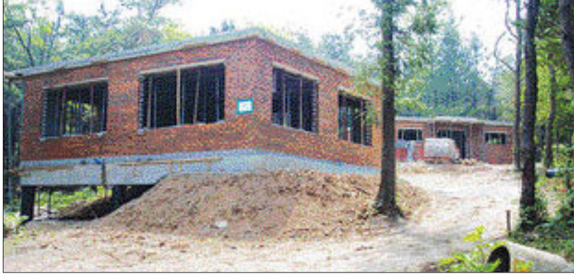
순천 시민들이 등산코스로 즐겨 찾는 죽도봉 공원에 들어서고 있는 일반 음식점 공사현장. /순천=김진수기자 jsk2229@
