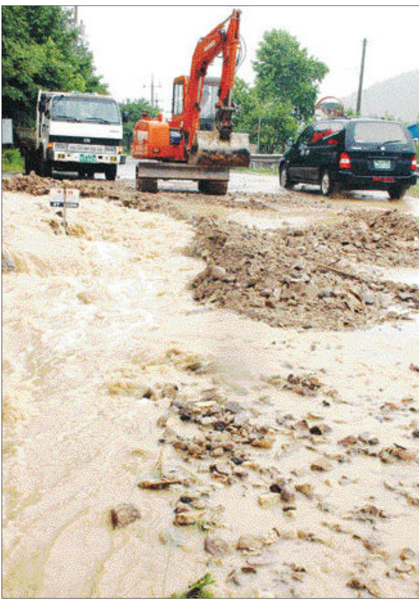
폭우에 막힌 도로 호우주의보 속, 25일 하루 81.5mm의 폭우를 견디지 못해 언덕의 흩더미가 무너져 내린 나주시 남평면 서산리 양 도로(남평~화순 간 822호 지방도). 장미전선에 들어간 광주·전남지방은 이날 승주에 최고 92mm의 비가 내렸으며, 26일까지 30~60mm의 비가 더 쏟아진 후 27일 잠시 소강 상태를 보일 전망이다. /나주=남평주기자 mjna@kwangju.co.kr
