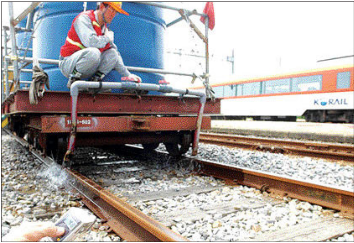
“철로를 식혀라” 연일 30도를 넘는 폭염이 계속되자 긴급 투입된 ‘평판화차’(平板貨車)가 호남선 광주 하남역 인근 레일에 물을 뿌리고 있다. 이 ‘평판화차’는 수온 17~20도의 지하수 등을 2천500ℓ 싣고 다니며 한번에 4km의 레일을 식힐 수 있다. /나명주기자 mjna@kwangju.co.kr
