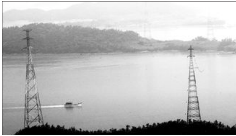
고압전선이 절단된 '신안 송전선로'. 앞쪽이 당사도, 뒷쪽은 암태도.
