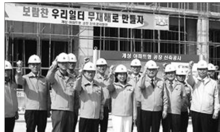
25일 개성공단을 방문한 현대그룹 현장은 개성 아파트형 공장 신축현장에서 현장관계자들을 격려한 뒤 함께 파이팅을 외치고 있다. /연합뉴스
