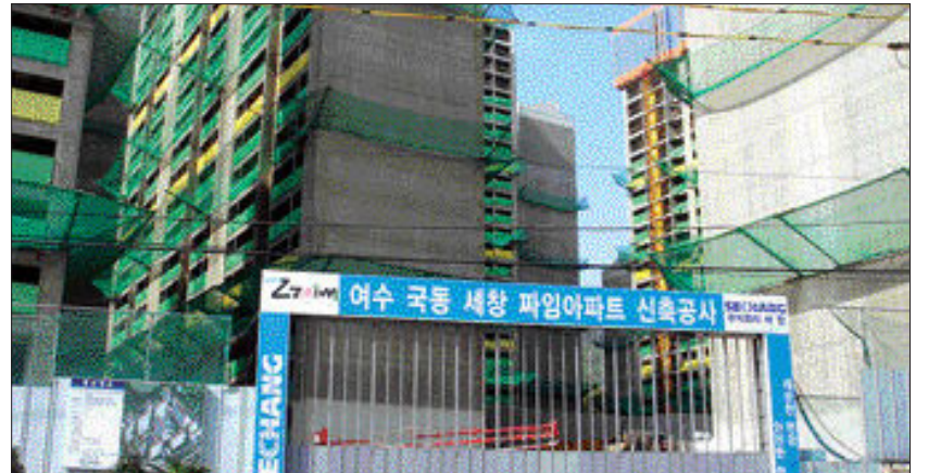
(주)세창이 건설하던 여수시 국동 주공 재건축 아파트의 공사 현장 출입문이 굳게 닫혀있다. (주)세창은 지난달 31일 100억여 원의 어음을 결제하지 못해 최종 부도처리됐다.
