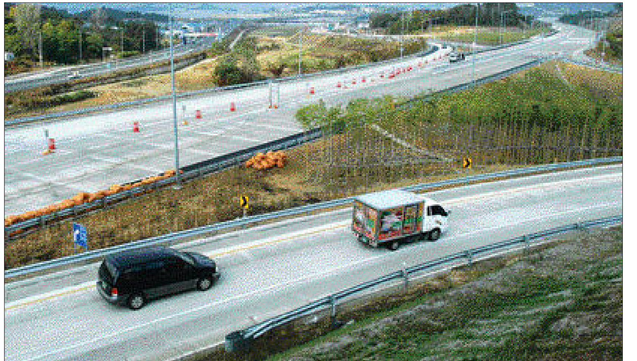
다음달 개통될 88올림픽고속도로 '고서~담양'구간 담양 IC의 모습. 왕복 4~6차로인 '고서~담양'구간 도로는 기존 도로보다 폭이 2~3배 넓으며, 거리도 1km 가까이 단축됐다. /담양=최현배기자 choi@kwangju.co.kr
