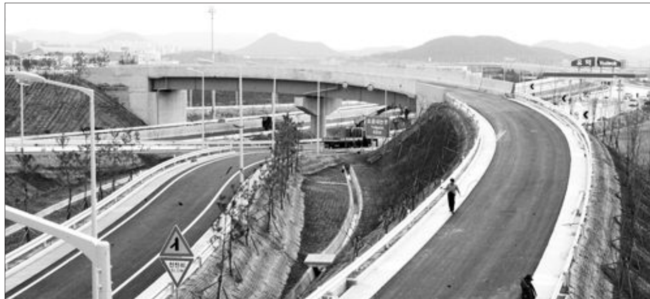
광주의 관문인 무진로와 제2순환도로를 잇는 유덕IC. 광주시는 제2순환도로 민자유치사업 4구간 중 일부인 유덕IC~서창IC간 2.48km 6차선 도시고속도로를 다음달 8일 조기 개통한다.
