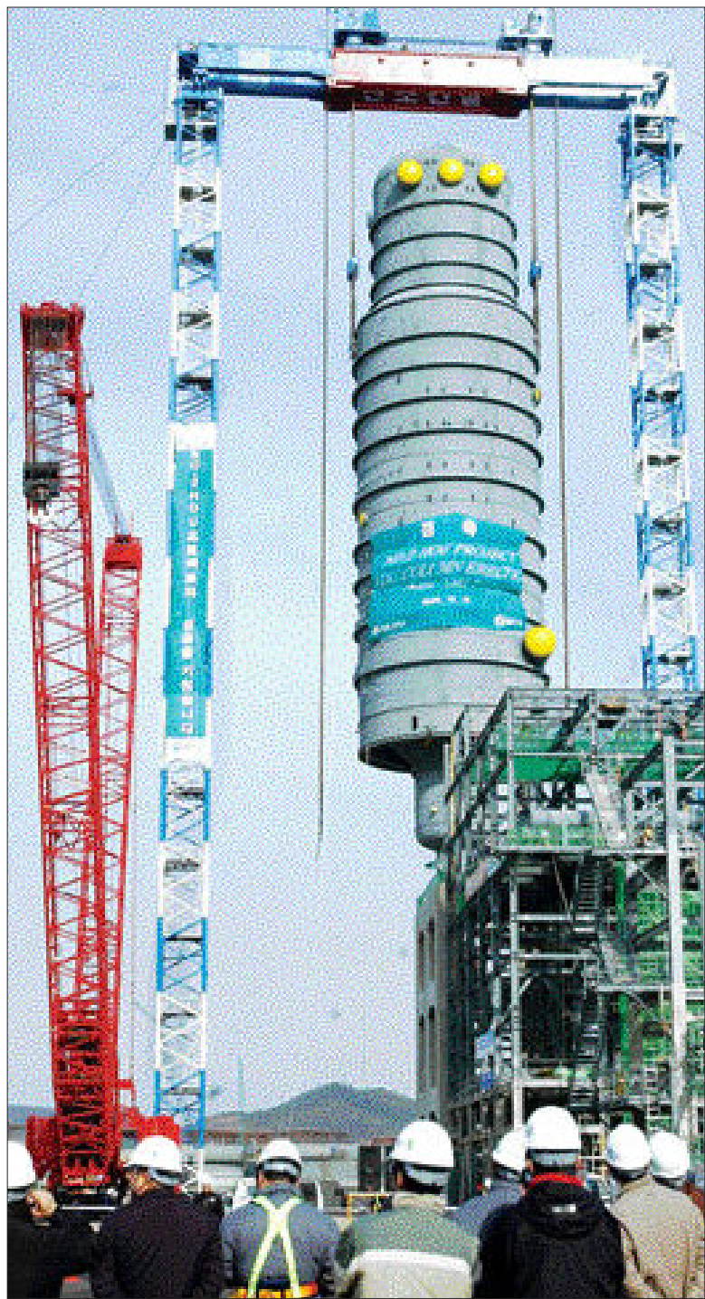
세계 최대 감압증류탑 19일 여수 GS칼텍스 제2중질유분해공정 시설에 세워지고 있는 높이 79.5m의 세계 최대 규모 감압증류탑. 대형 크레인이 감압증류탑을 콘크리트 기초 구조물(높이 24.7m)안에 넣고 있다. /여수=위직량기자 jwji@kwangju.co.kr
