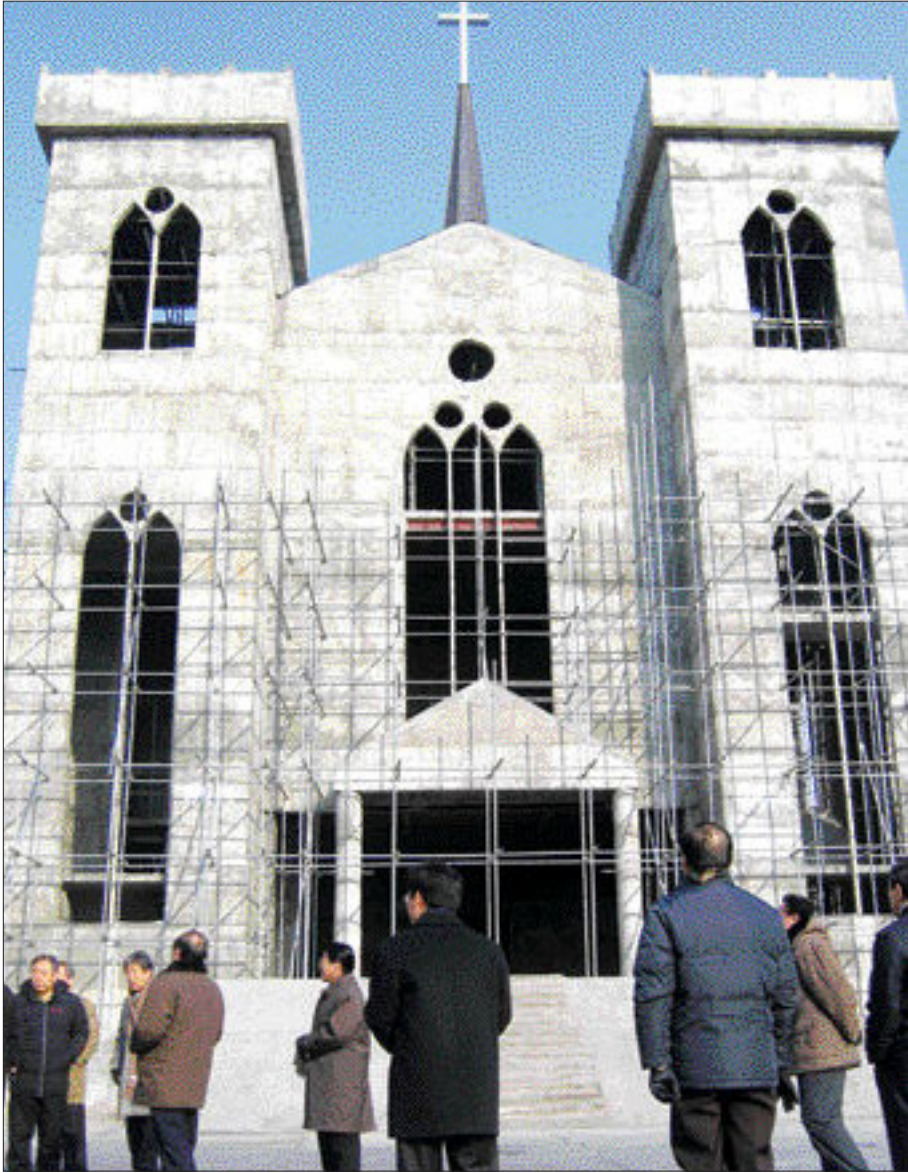
평양 봉수교회 재건축 현장 김용덕·강상용 장로를 비롯한 10명의 대한예수교장로회 통합 대표들이 지난 1일 평양을 방문, 봉수교회 재건축 현장을 살펴보고 있다. /연합뉴스
