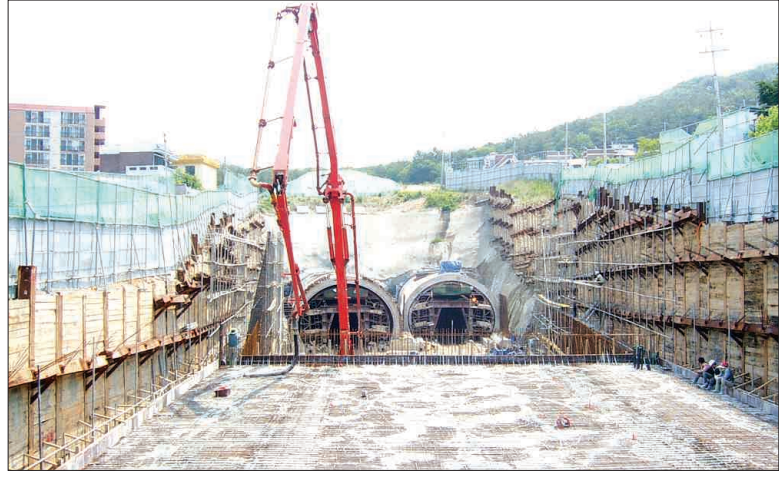
목포 구도심과 신도심을 연결하는 목포경찰서~버스터미널 간 도로 개설공사기 당초 보다 1년 연장된 연말까지 완공될 예정이다. 사진은 터널 공사 현장.
