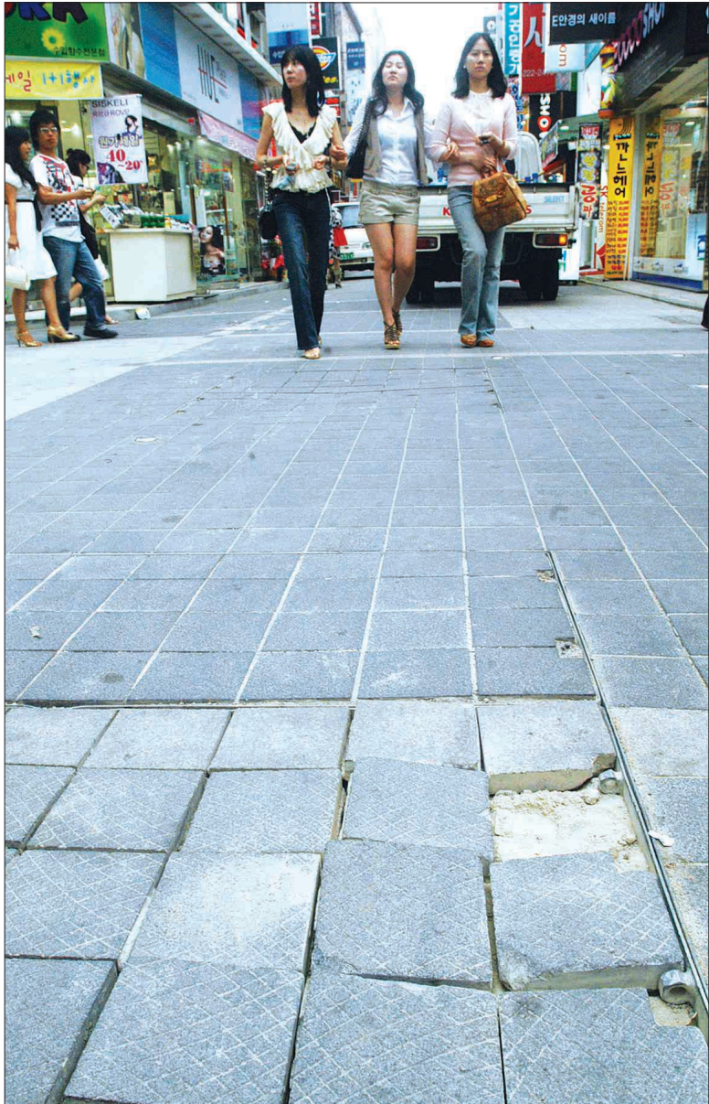
광주 충장로를 특화의 거리로 조성하기 위해 보도 포장공사가 실시되고 있는 충장로 1가 입구. 맨홀 부분의 포장 상태가 제대로 이뤄지지 않아 바닥재가 깨지고 뒤물러 있다. /최희기자 choi@kwangju.co.kr
