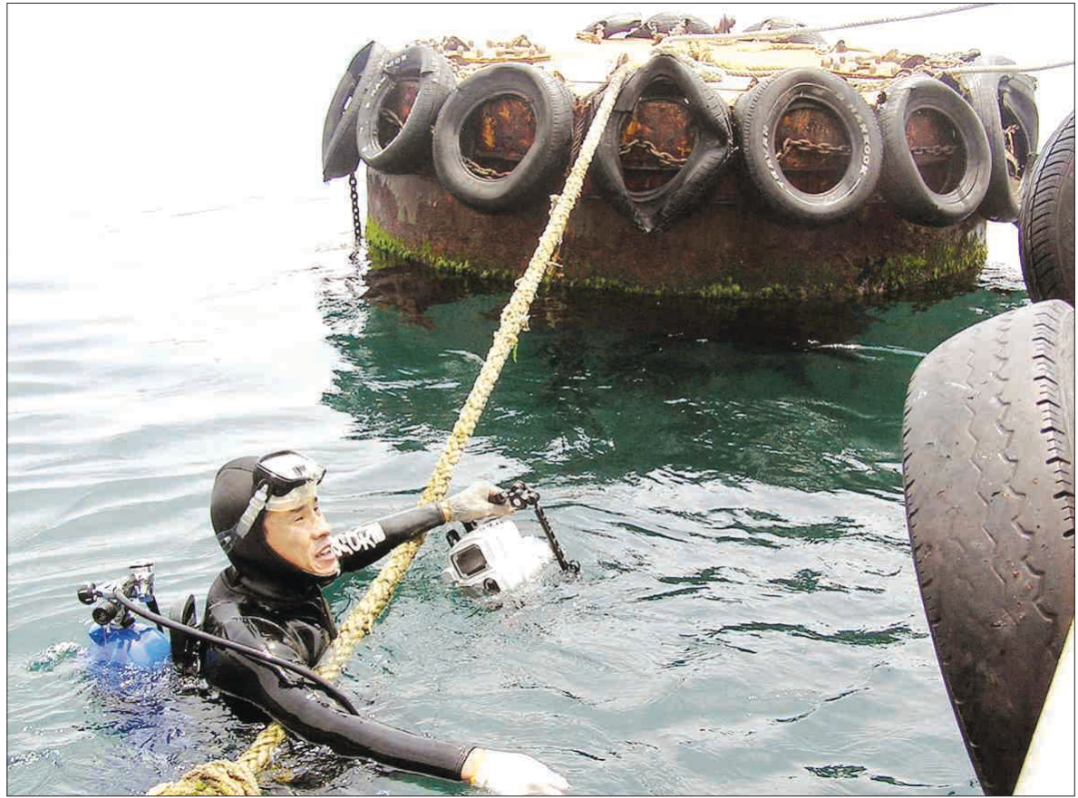
서해지방해양경찰청 특공대원들이 태풍 발생에 대비, 신안 흥도에 설치된 '선박 계류 부이' 점검에 나섰다. 선박을 계류시키기 위한 이 시설은 콘크리트로 만든 추와 닻을 이용해 바다 밑에 고정돼 있다. 흥도 부이는 1천급 경비정 1척이 계류할 수 있다. /연합뉴스
