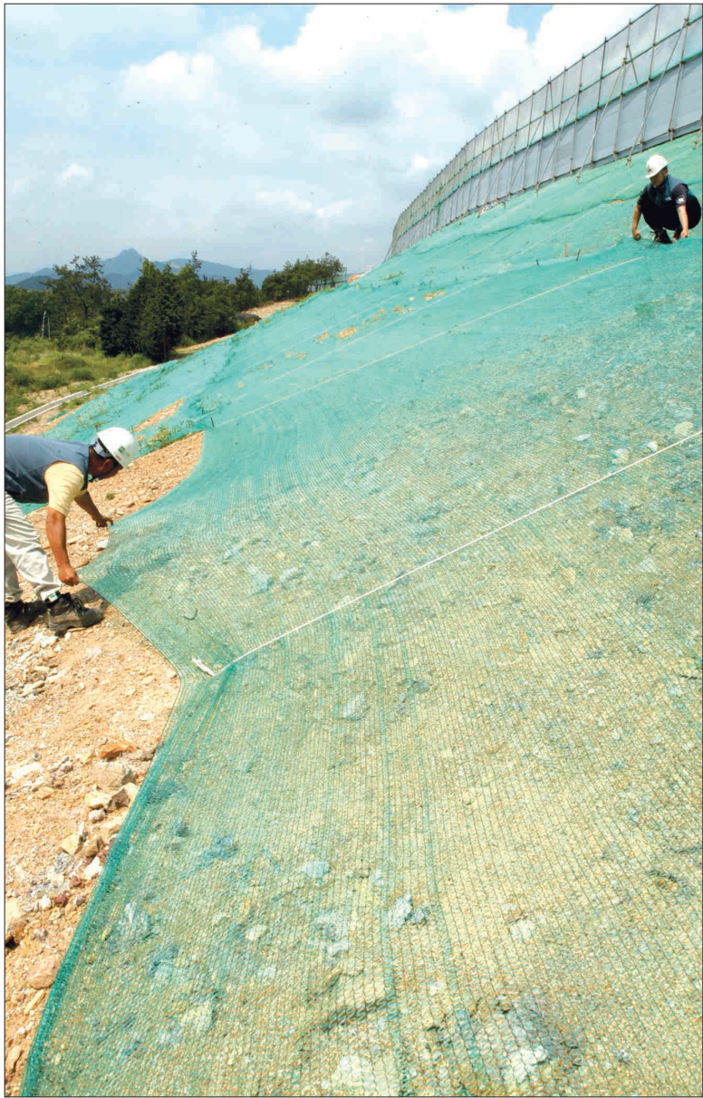
21일 광주·전남을 비롯, 전국이 장마권에 접어들지만 광주·전남 상습 침수지역과 절개지 등의 재해 위험은 상존해 있다. 20일 화순 능주~이양간 도로 확장 현장에서 인부들이 장마에 대비한 보호망을 도로 옆 절개지에 설치하고 있다. /최현배기자 choi@kwangju.co.kr
