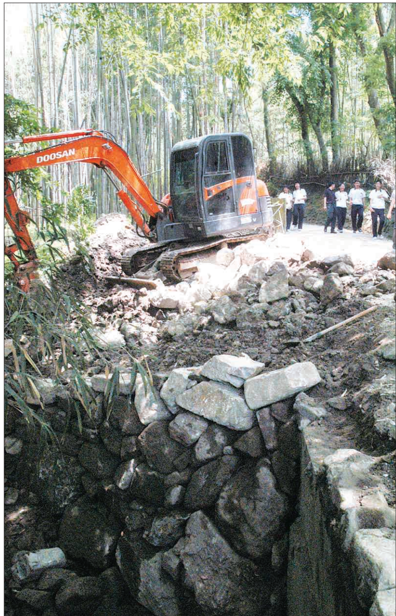
소쇄원 내 광풍각(光風閣) 앞 계곡의 석축(石築). 높이 3m·길이 30m 가량이 무너졌고, 배수로도 사라지고 있다. /담양=최현배기자 choi@kwangju.co.kr
