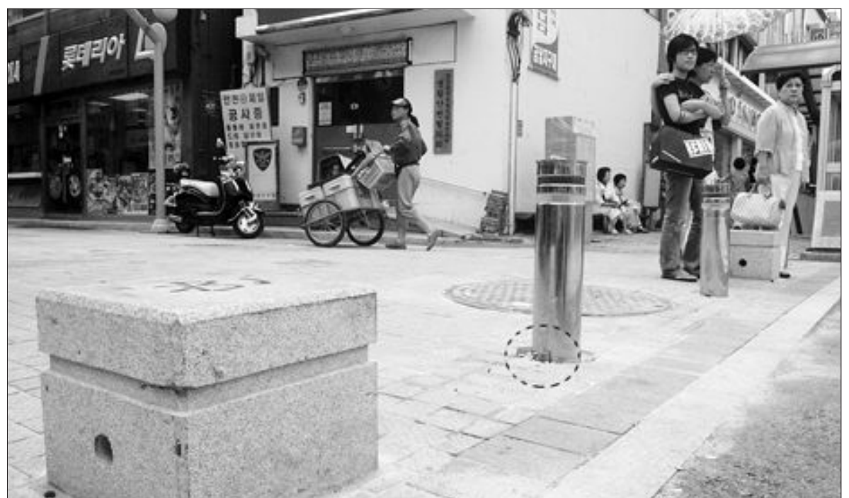
광주시 동구 충장파출소 앞에 설치된 '자동차 진입 억제 말뚝'. 광주시가 차 없는 거리 조성 사업으로 충장로 일대 8곳에 이같은 쇠 말뚝을 설치해 자물쇠(점선 부분)를 채웠지만 소방차 진입이 어려워 화재 발생시 대형 참사로 이어질 수 있다는 지적이다. /최현배기자 choi@kwangju.co.kr
