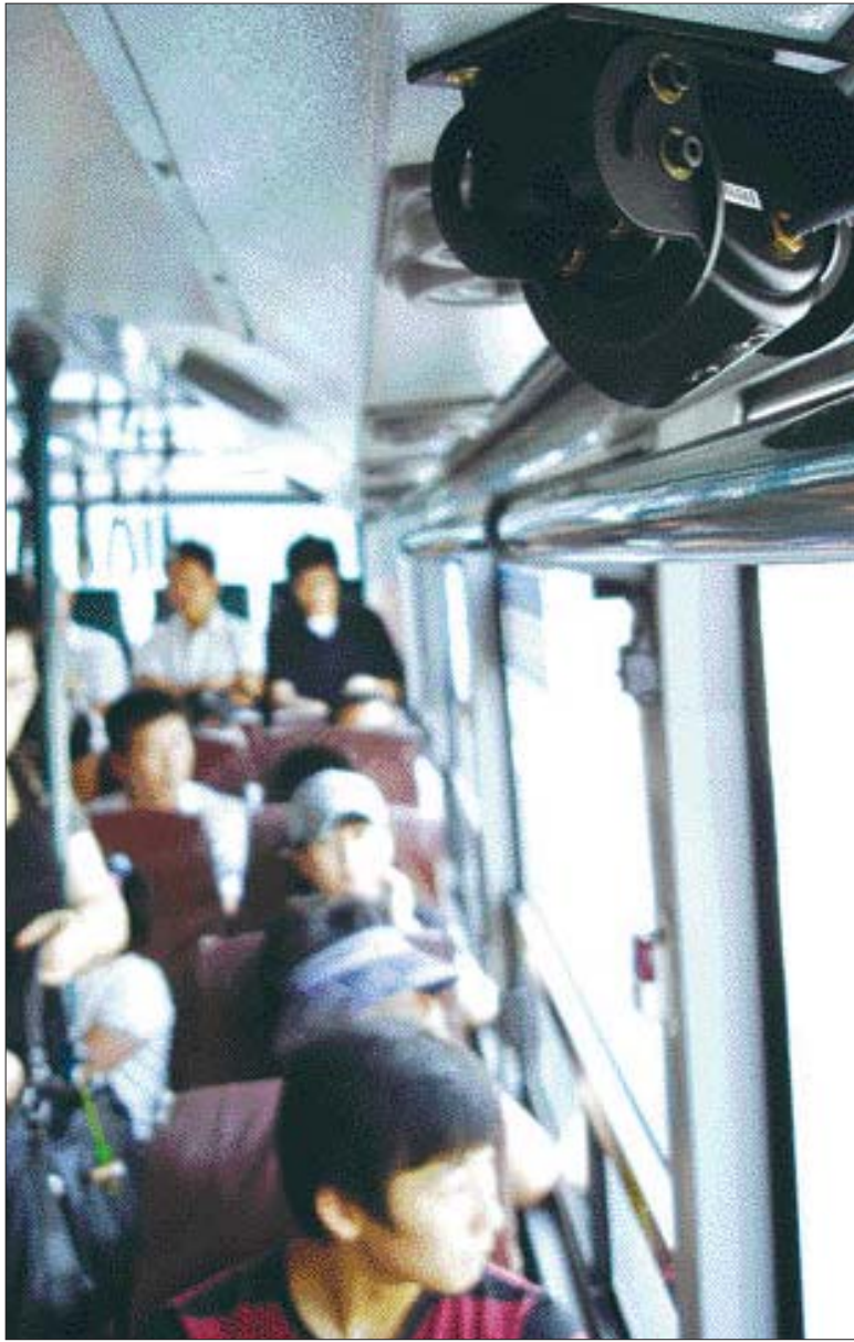
승객 감시용 CCTV 카메라가 설치된 광주시내버스 내부. 4대의 CCTV 카메라 승객들의 움직임을 24시간 촬영·녹화할 수 있다.
