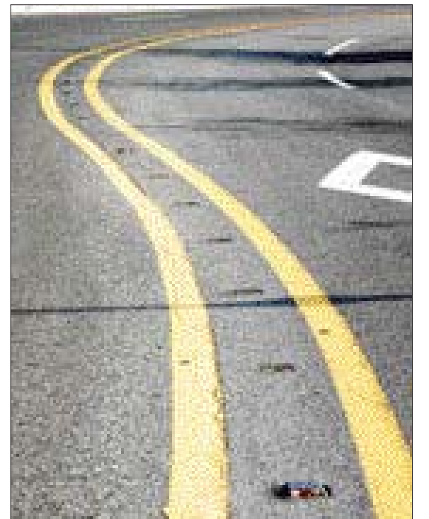
목포시내 일부 도로의 교통시설물이 부실하게 관리되면서 운전자들의 안전이 위협받고 있다. 중앙선 차선 표지병이 사라진 유달산 일주도로 구간.
