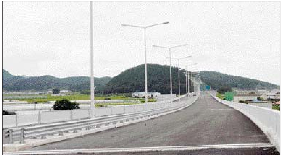
고흥읍~도양읍 4차선 확·포장 마무리 고흥군 고흥읍과 도양읍을 연결하는 국도 27호선 18.9km 구간의 4차선 확·포장 공사가 13일 준공됐다. 지난 2001년 6월에 착공된 이 공사는 1천466억원이 투입돼 인터체인지(IC) 6개소와 간이 휴게소 3개소, 교량 27개소 등이 설치됐다. 이번 개통으로 거리는 1.1km 줄어 들고 통행시간도 25분에서 14분으로 단축됐다. 한편 녹동항과 소록도, 거금도를 연결하는 공사는 오는 2011년 12월 완공된다. /고흥=주각중기자 gju@
