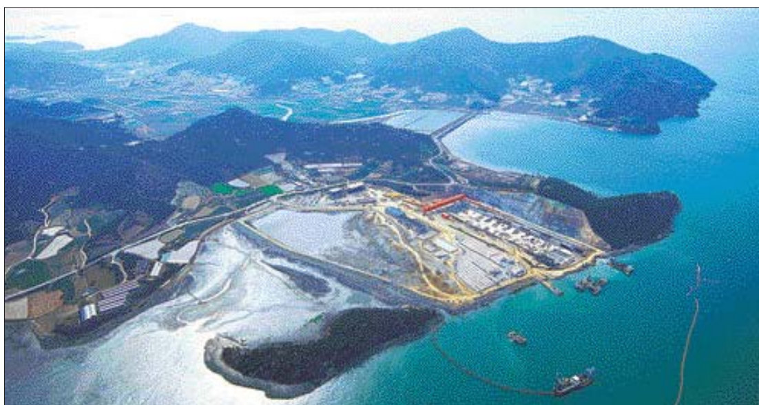
세계 최대 규모로 건설되고 있는 해남군 화원면 대한조선 단지. 대한조선의 해남조선소 건설 프로젝트가 완성되면 2015년 연 매출 10조원에 인구 20만명의 배후도시가 조성돼 산업지도를 확 바꿀게 된다. (광주일보 자료 사진)
