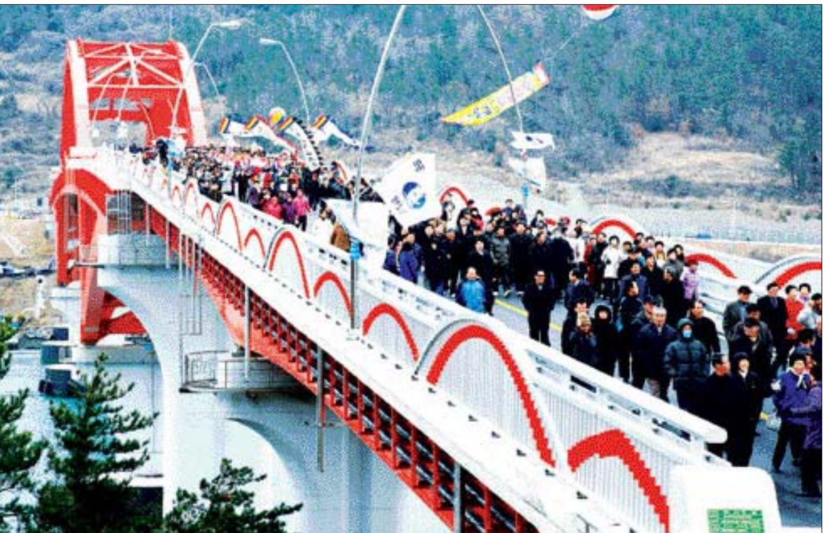
완도 노화도와 보길도를 연결하는 '보길대교'가 29일 개통돼 고산 운선도 유적지를 찾는 관광객과 도서 주민들의 교통 불편이 해소됐다. 금강기업이 시공한 보길 대교는 교량 길이 620m와 접속도로 1.4km로 사업비 539억원이 투입돼 8년여 공사 끝에 준공됐다. /원도=정은조기자 ejchung@
