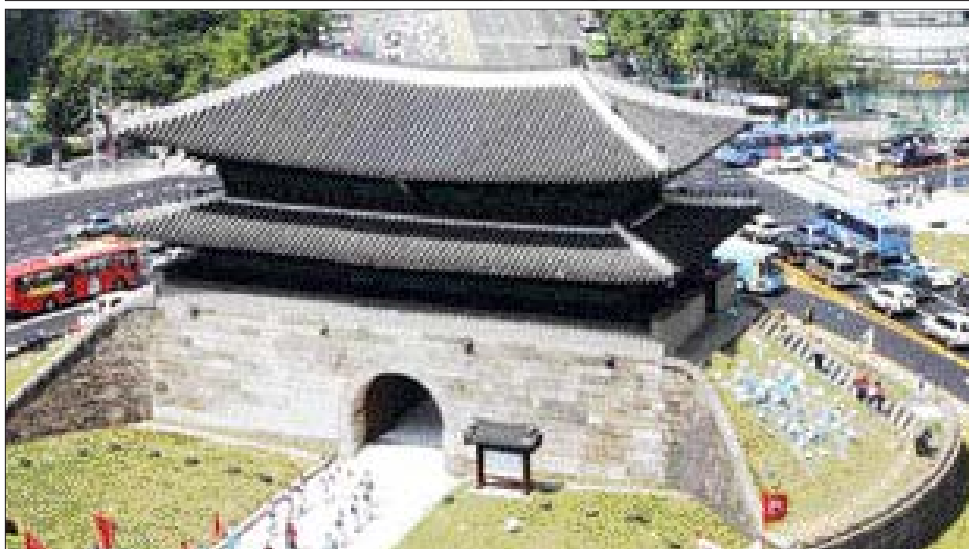
11일 화마로 쓰러진 국보 1호 승례문 앞에 시민들이 놓은 국화꽃이 안타까움을 더하고 있다(사진 위). 아래는 지난 2006년 3월 시민들에게 개방할 당시 모습. /연합뉴스
