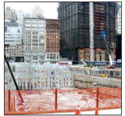
공사가 한창인 9·11 테러 현장
