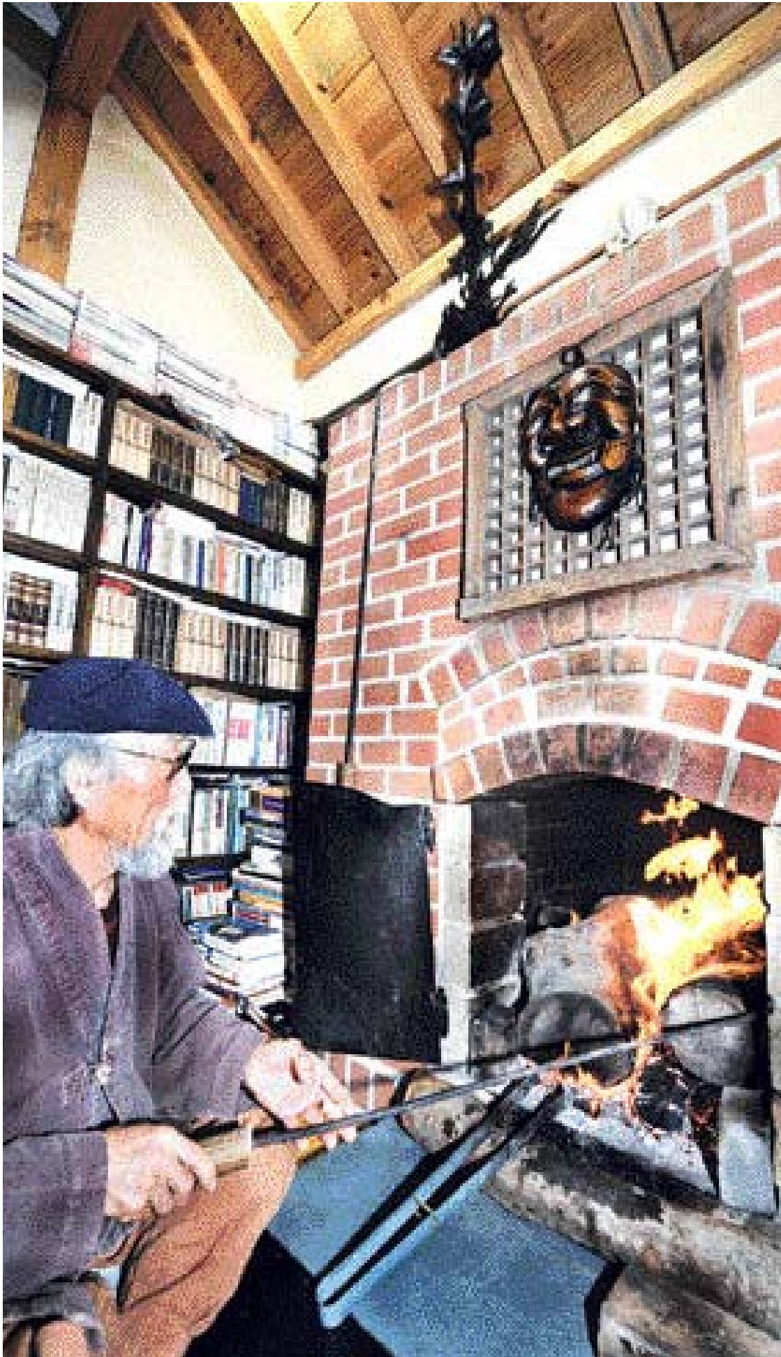
거실에 설치된 벽난로는 안전을 고려해 제철소 고로용 내화벽돌로 만들었다. /위직량기자 jrwi@kwangju.co.kr
