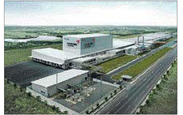
베트남 호치민시 인근 빈증성에 세워진 금호타이어 래디얼 타이어 생산공장 전경. (금호타이어 제공)
