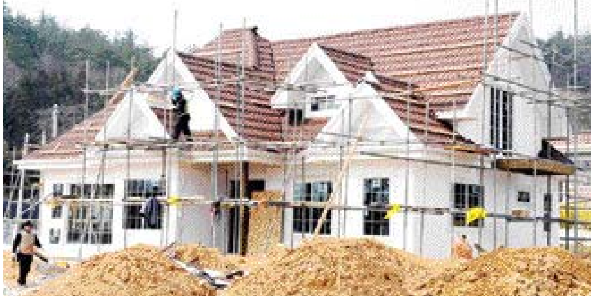
광주우드하우스 직원들이 나주시 남평면 우산리에서 43평형대 미국식 목조주택을 짓고 있다. 지난 2월 중순 시작한 공사는 50%의 공정을 넘어섰으며, 현재 지붕 작업이 진행중이다. /나명주기자 mjna@kwangju.co.kr
