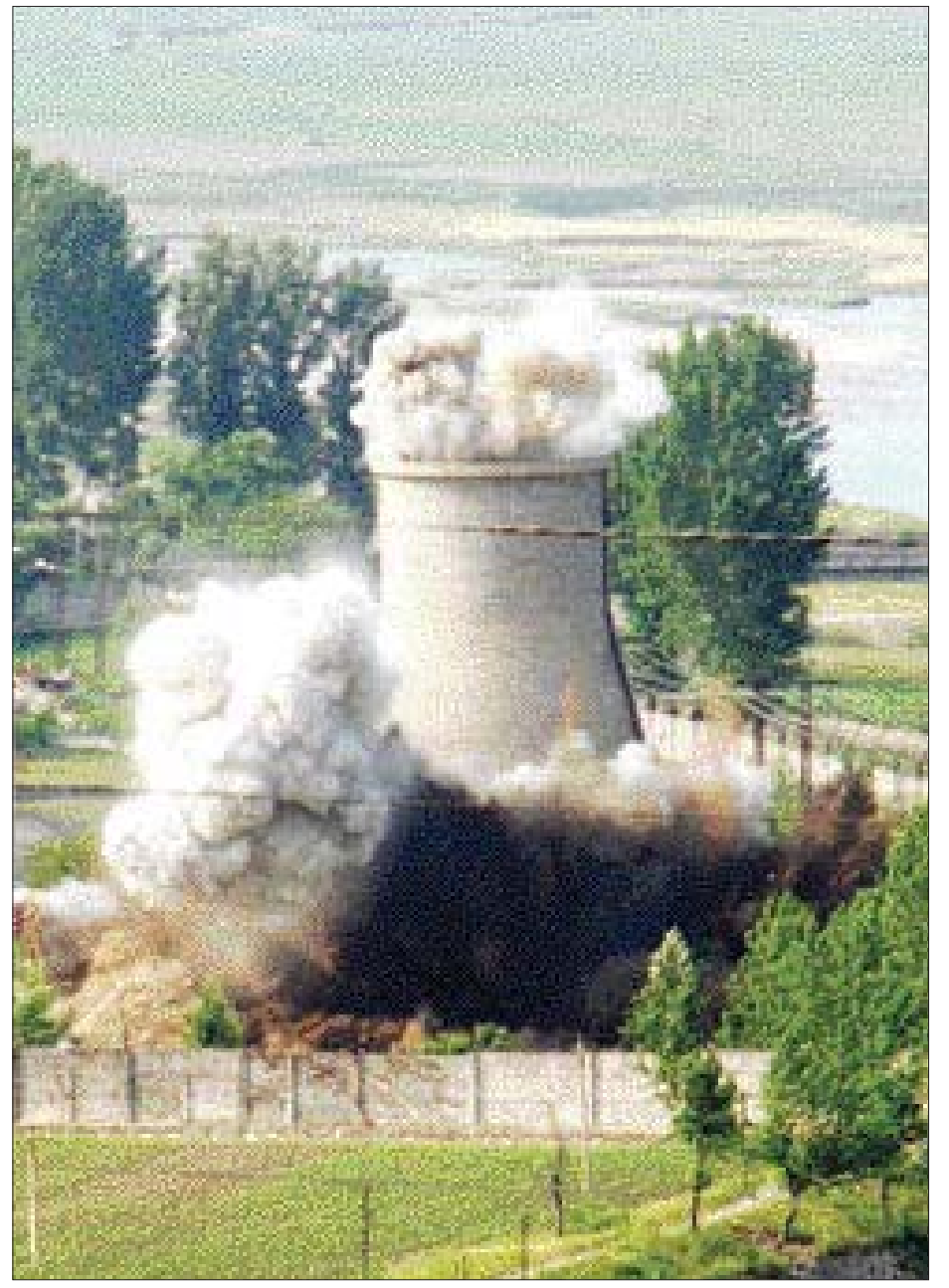
북한은 27일 오후 5시 5분께 성 김 미국부 한국과장을 비롯한 주요 인사와 미 CNN 등 6차 회담 참가국 언론사 등이 지켜보는 가운데 영변 원자로 냉각탑을 폭파했다. 북한측은 높이 20m의 콘크리트 구조물인 냉각탑을 폭파하기 위해 200kg의 다이내마이트를 사용한 것으로 알려졌다. ▶ 관련기사 2면 /연합뉴스
