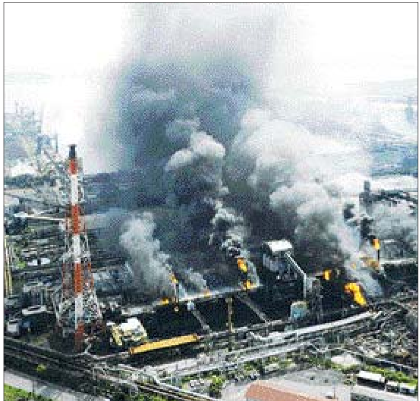
신일본제철 공장 화재 29일 일본 서남부 후쿠오카현 기타큐슈에 있는 신일본제철 공장에서 화재가 발생했다. 회사 측은 이날 철근과 강관을 만들어내는 생산라인을 일시적으로 정지할지 아직 결정하지 못했다고 밝혔다. /연합뉴스
