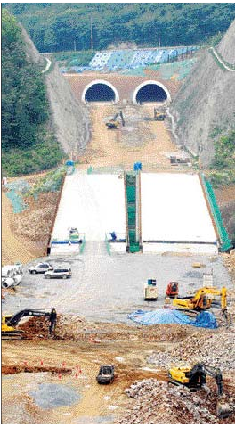
여수시 돌산면 우두리와 소리면 덕양리를 잇는 국도 17호선 대체 우회도로(18.7km) 공사가 한창이다. 여수시는 2012 세계박람회의 성공 개최와 광양만권 경제자유구역의 활성화를 위해 광역교통망과 박람회장을 연계하는 주요 도로망 확충사업에 전 행정력을 집중하고 있다. /여수=박양규기자 ykpark@
