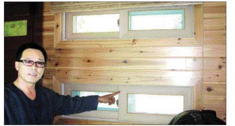
한옥건축에서 응용한 통풍시스템. 계절에 따라 바람의 방향이 다르다.
