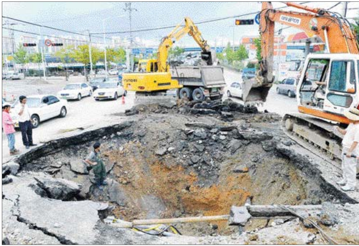
출근길 도로 한복판 '폭삭' 2일 오전 8시께 광주시 광산구 신가동 극락사거리 도로 밑 송수관로가 누수되면서 지름 5m, 깊이 6m의 도로 한복판 지반이 붕괴됐다. 인명피해는 없었으나 이 사고로 출퇴근 시민들이 큰 불편을 겪었다. 앞서 지난 1일 오후에도 사고 지점에서 100m 떨어진 송수관로에서 물이 역류해 이 일대 도로가 침수되는 사고가 발생했다. /최현배기자 choi@kwangju.co.kr
