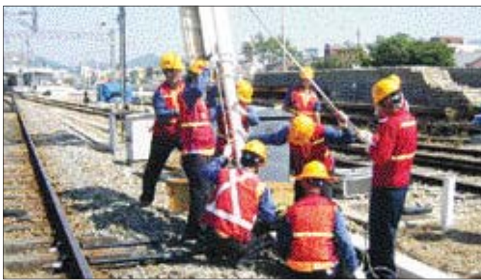
코레일 광주지사(지사장 백종찬)는 최근 호남선 장성역에서 철도 이용객들의 안전을 위한 비상사고 복구 모의훈련을 시행했다. 이번 훈련은 출발신호기가 파손돼 고속열차가 통제될 경우를 가정해 신속한 임시신호기 설치와 신호보안장치의 가동 등을 점검했다.
