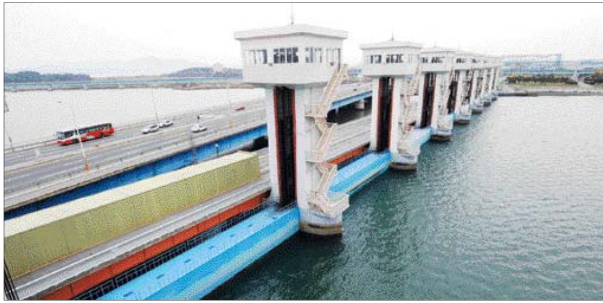
내년도 정부 예산안에 영산호 배수갑문과 통신문 확장 등 남도의 젖줄인 영산강을 살려내기 위한 주요 사업비가 반영돼 전남도가 추진중인 '영산강 뱃길복원 프로젝트'가 탄력을 받게됐다. 영산강 하구연 배수갑문 전경.
