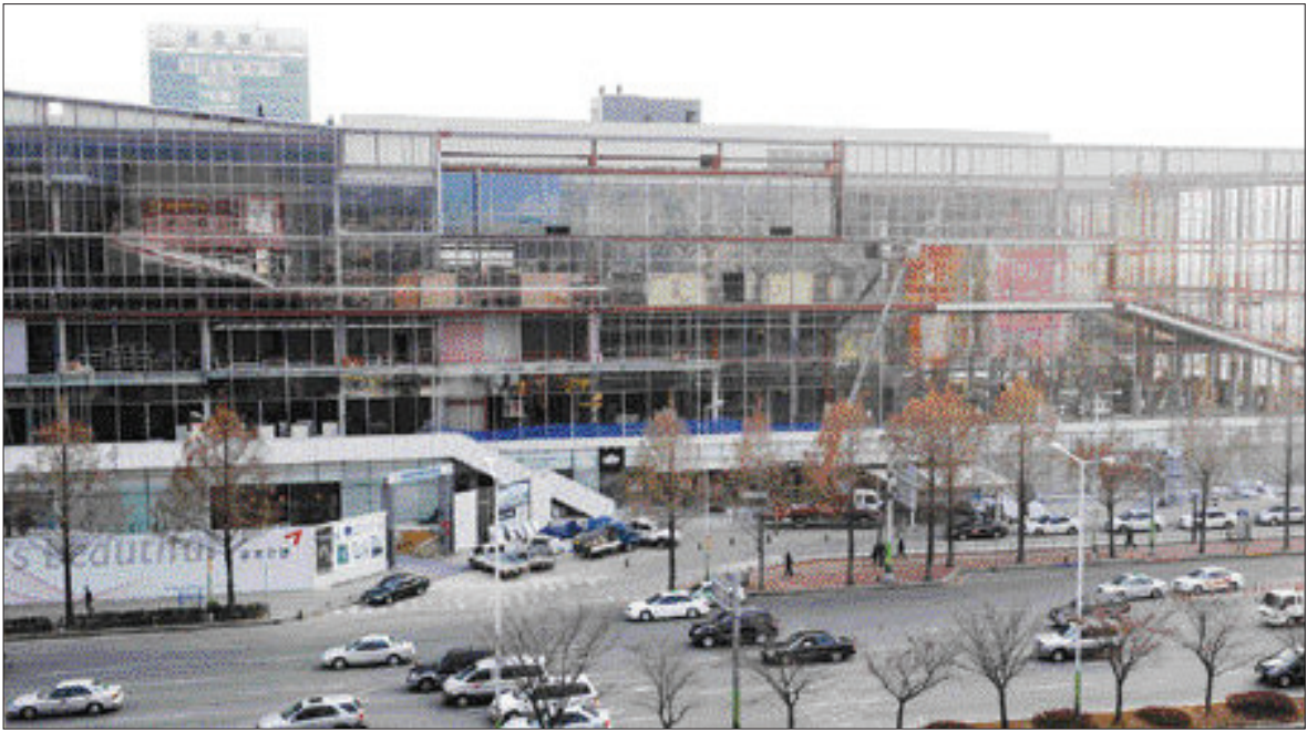
금호아시아나그룹은 내년 5월 광주 서구 광천동 중합버스터미널에 미술관, 공연장, 음악홀을 갖춘 복합문화공간 '유스퀘어 문화관'을 개관한다. 사진은 막바지 공사가 한창인 '유스퀘어 문화관' 전경.
