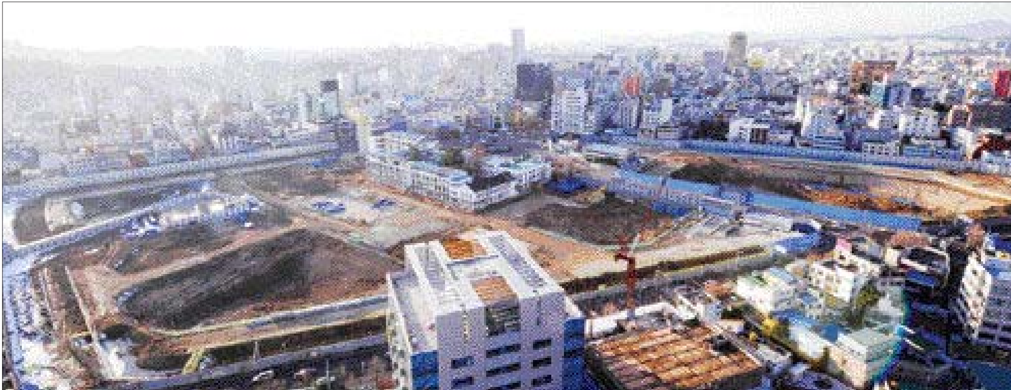
국립 아시아 문화전당 내 옛 도청 별관 철거 논란의 장기화로 지난해 12월부터 공사가 전면 중단된 문화전당 건립 부지 전경.
