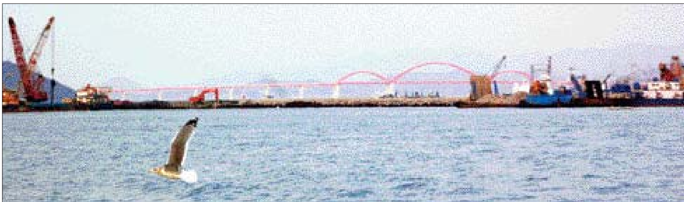
여객선을 쫓는 갈매기 뒤로 목포시 연산동과 신안군 압해도를 잇는 압해대교의 모습이 보인다.
