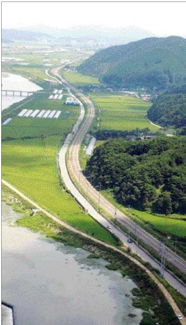
호남고속철 조기 개통이 미뤄지면서 수십년 동안 구불구불한 선로로 남아있는 호남선의 장성~정읍 구간. <광주일보 자료사진>
