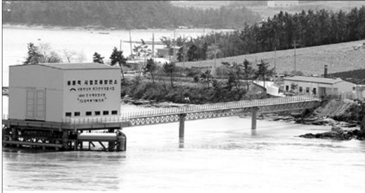
울돌목에 설치된 ‘세계 최대급’ 시험 조류발전소. 오는 14일 준공식을 열고 본격적인 전기생산에 들어갈 이 조류발전소에는 500KW 발전기 2대가 설치됐다.
