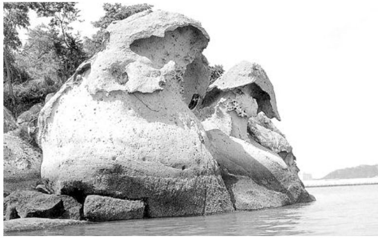
보존용역보고회 “갯 부분 균열 붕괴 우려”
