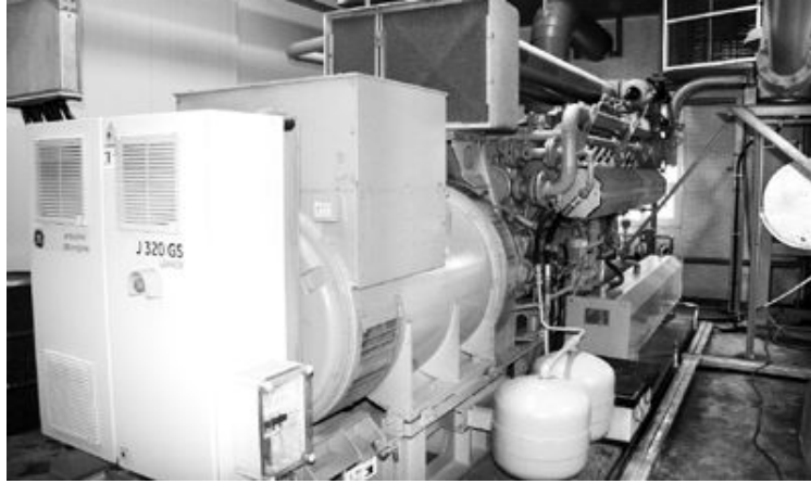
발전소는 925kW급 가스엔진 2기로 구성돼 있다. 이미 건설된 1호기는 정상적으로 가동돼 전기를 생산하고 있다. 2호기는 시험가동 중에 있어 조만간 발전과 전기공급계약을 체결한 뒤
