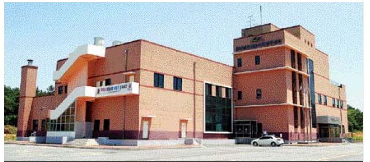
화순 의약품단지에 지리한 전남도 생물의약품연구센터 전경.
