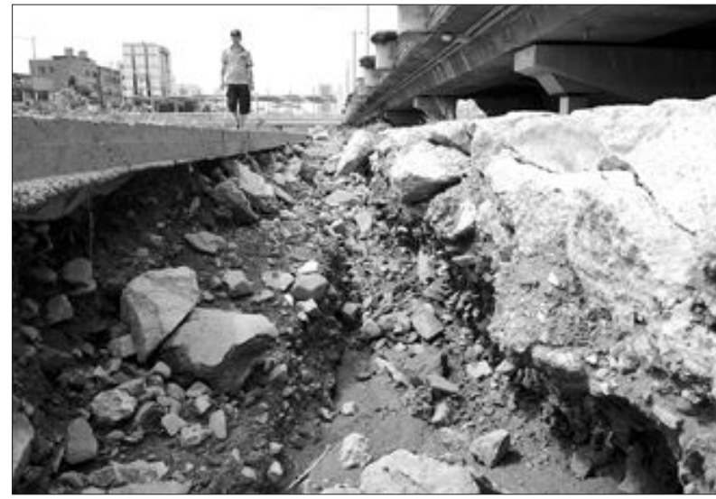
힘쓸러 가고... 쌓이고... 파이고... 장마가 물러간 29일 자연형하천정화사업 구간인 광주천 중·상류 곳곳에 폭우로 유실되거나 파헤쳐진 생채기가 드러났다. 집중호우로 유실된 자연석 호안(왼쪽)과 시멘트·화강암으로 조성된 바닥이 20m 이상 사라지고 토사가 쌓인 둔치(가운데). 오른쪽은 50cm 이상 파여나간 자연거도로 옆의 시멘트 바닥. /최현배기자 choi@kwangju.co.kr
