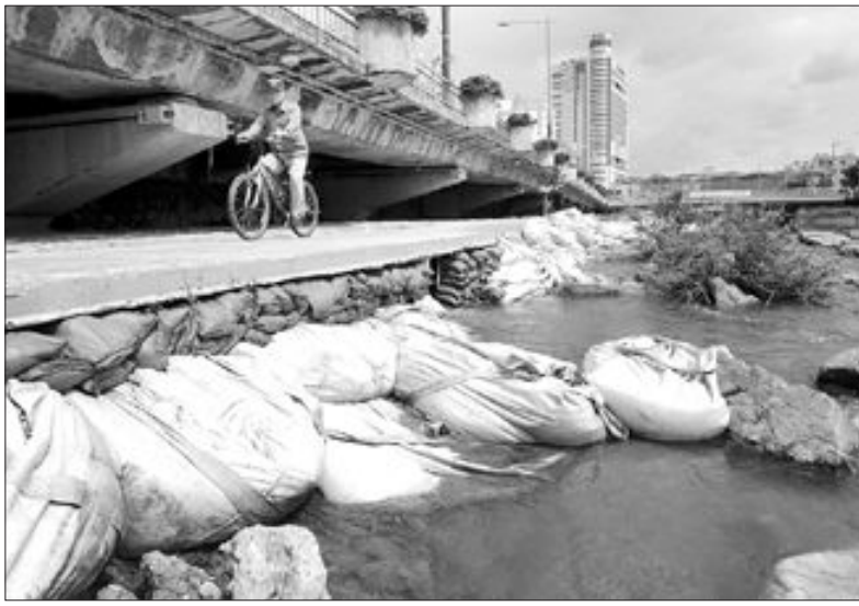
힘쓸러 가고... 쌓이고... 파이고... 장마가 물러간 29일 자연형하천정화사업 구간인 광주천 중·상류 곳곳에 폭우로 유실되거나 파헤쳐진 생채기가 드러났다. 집중호우로 유실된 자연석 호안(왼쪽)과 시멘트·화강암으로 조성된 바닥이 20m 이상 사라지고 토사가 쌓인 둔치(가운데). 오른쪽은 50cm 이상 파여나간 자연거도로 옆의 시멘트 바닥. /최현배기자 choi@kwangju.co.kr
