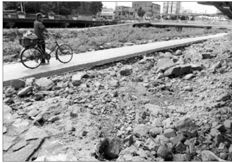
힘쓸러 가고... 쌓이고... 파이고... 장마가 물러간 29일 자연형하천정화사업 구간인 광주천 중·상류 곳곳에 폭우로 유실되거나 파헤쳐진 생채기가 드러났다. 집중호우로 유실된 자연석 호안(왼쪽)과 시멘트·화강암으로 조성된 바닥이 20m 이상 사라지고 토사가 쌓인 둔치(가운데). 오른쪽은 50cm 이상 파여나간 자연거도로 옆의 시멘트 바닥. /최현배기자 choi@kwangju.co.kr
