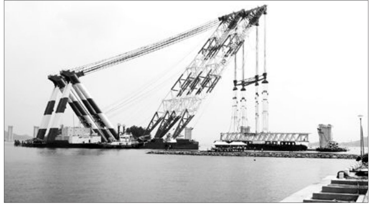
고흥 거금 연도교 첫 상판 고흥군 거금도와 소록도를 연결하는 연도교 첫 상판 거치공사가 지난 21일 3천 600t급 대형 해상장비 크레인을 동원해 진행됐다. 오는 2011년 12월 완공될 거금도 연도교는 총연장 6.67km에 달하며, 사업비는 2천498억원이 투입될 예정이다. /동부취재본부=주각중기자 gjuu@
