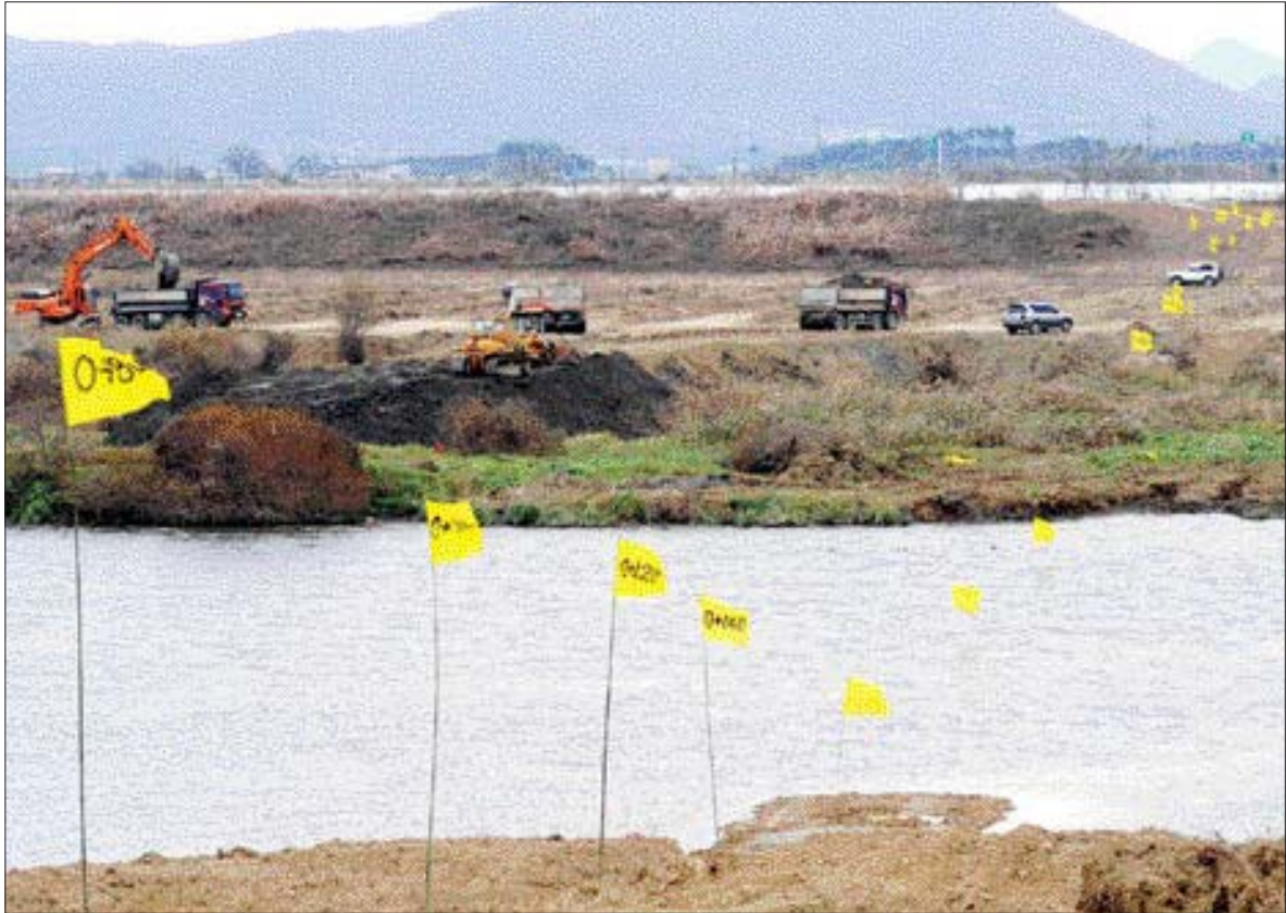
영산강 살리기 사업이 본격 진행 중인 19일 나주시 노안면 학산리 6공구 승촌보 건설현장에서 중장비를 동원한 토사 반출 작업이 활기를 띠고 있다. 노란 깃발이 꽂아진 곳은 보가 설치될 위치. /최현배기자 choi@kwangju.co.kr
