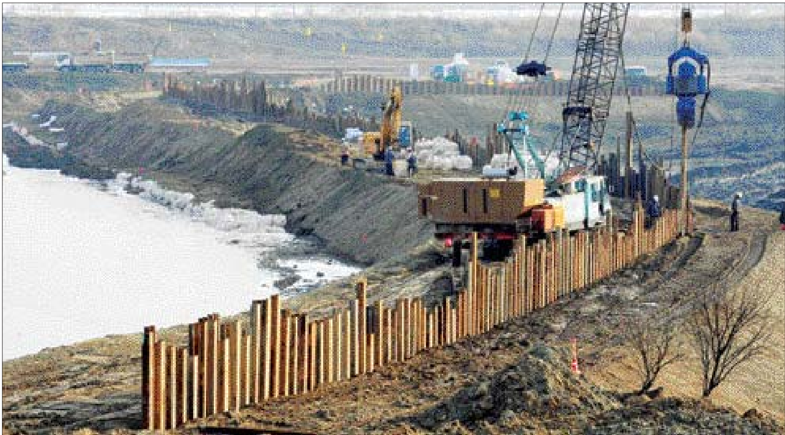
영산강 물막이 공사 4대 강 예산 내에서도 영산강에서 착공된 2개 보 가운데 승촌보의 임시 물막이 작업이 마무리됐다. 임시 물 막이 안에 콘크리트 구조물로 된 보를 만들기 위해 철 구조물을 이용한 터 피기 작업이 진행되고 있다. /나명주기자 mjna@
