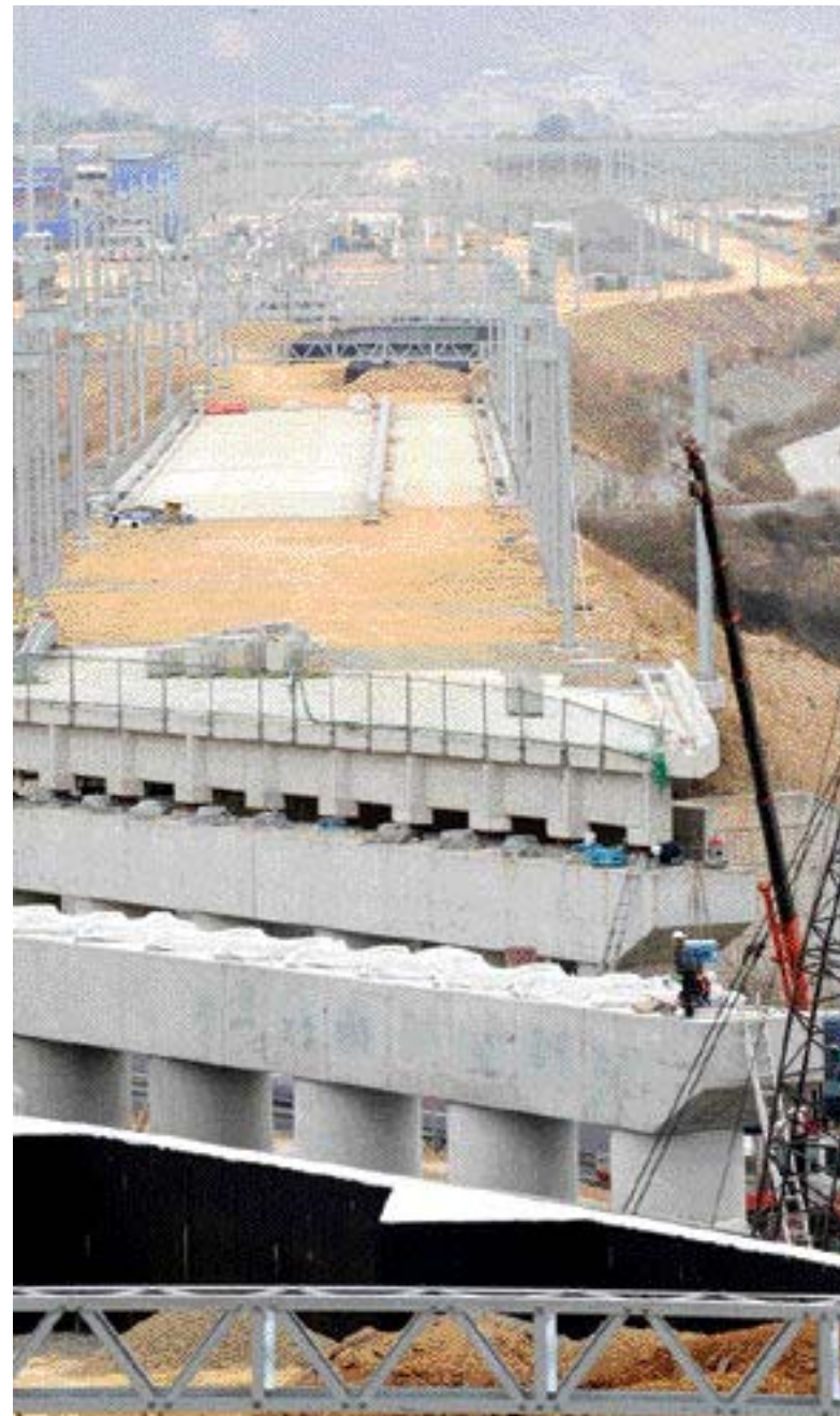
전라선 복선화 공사 한창
