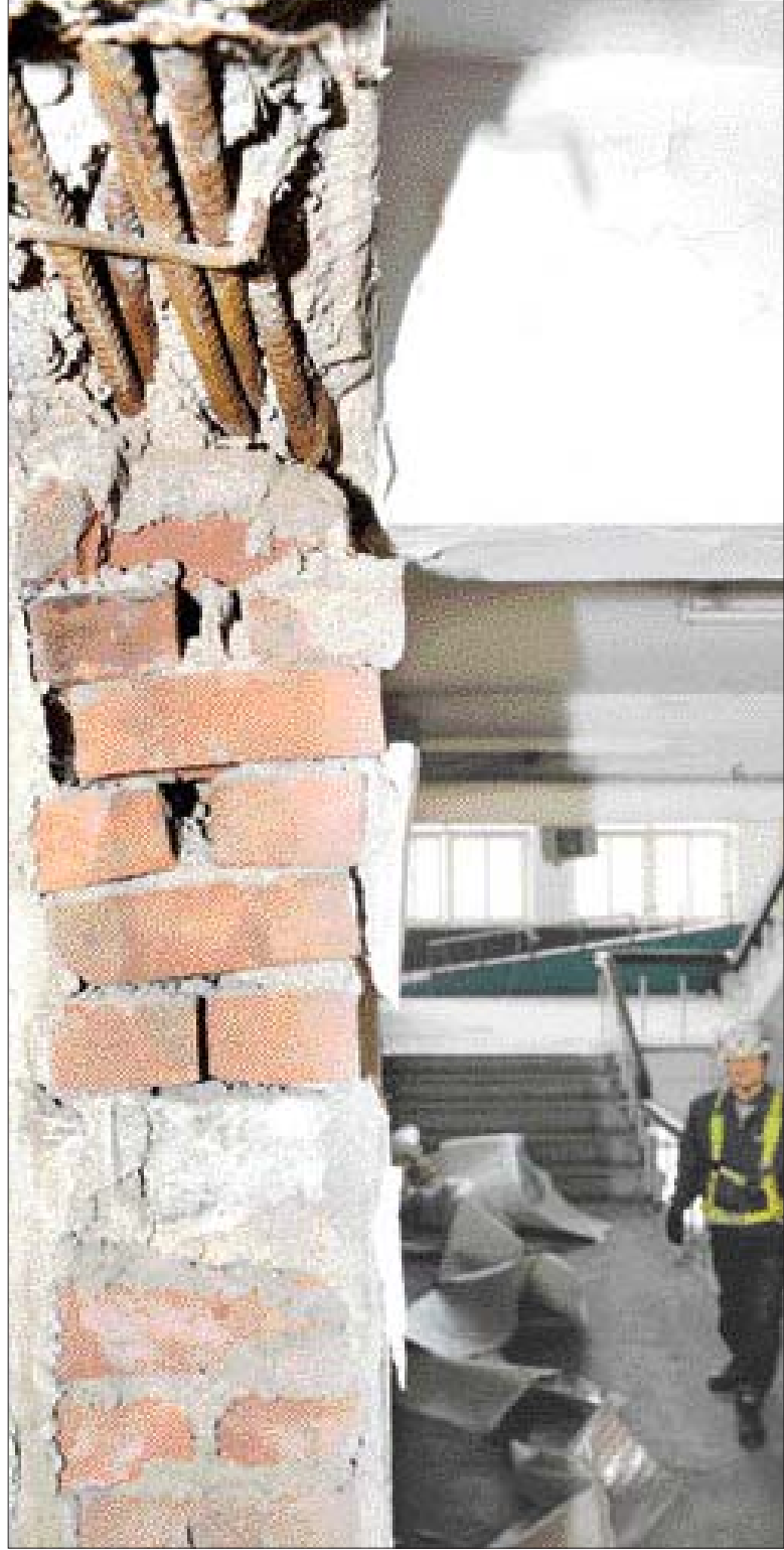
옛 전남도청 별관 내 심하게 균열이 간 벽돌로 쌓은 기둥. 안전진단 결과 별관 곳곳에 균열과 콘크리트 해체 등이 계속돼 건물을 더 이상 사용할 수 없는 지경인 것으로 조사됐다. /최현배기자 choi@kwangju.co.kr
