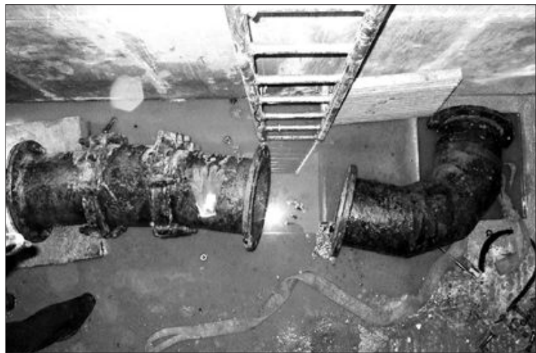
21일 새벽 수돗물 송수관 사고가 발생한 강진군 강진읍 서성리 장전마을 입구의 밸브실 지하.
